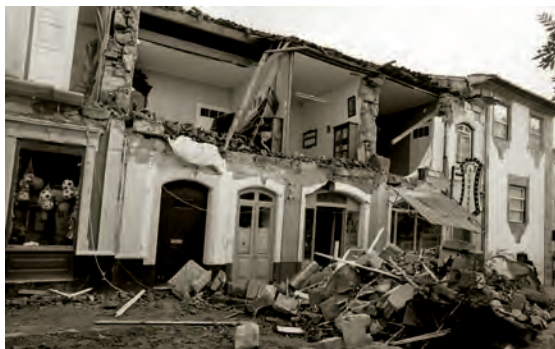
Casas em ruínas na sequência do terramoto de 1980, Ilha Terceira, Açores.
